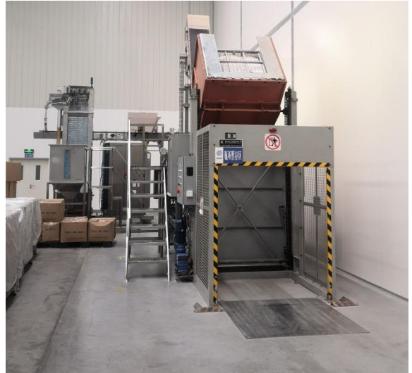
瓶坯、瓶盖上料、暂存
